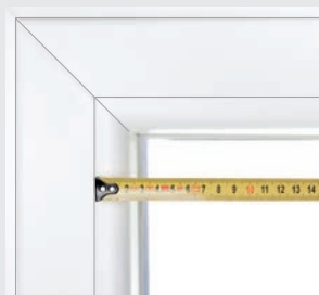
Empfohlener Messpunkt: Glasleistenfuge ggf. auf Beschläge achten
