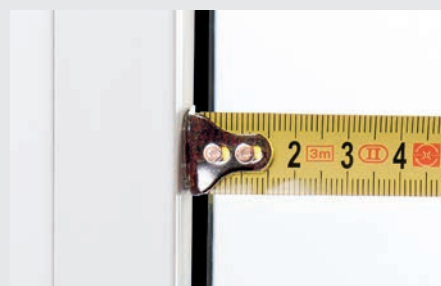
Gummidichtung schmaler als 5 mm
